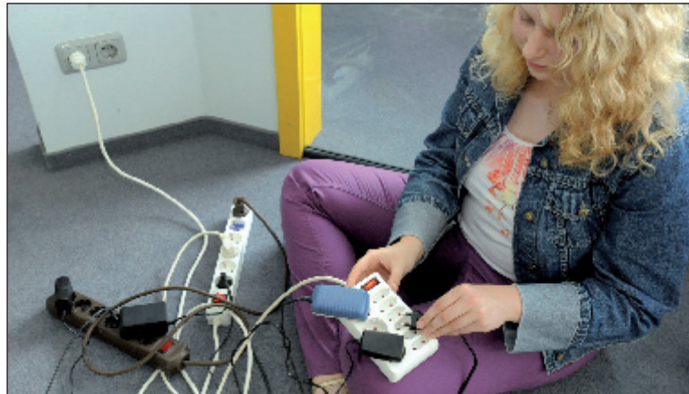
Mehrere Steckdosenleisten sollten nicht hintereinander geschaltet werden Foto: max
