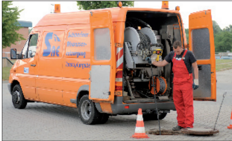
Die Mitarbeiter der WAG sind im Auftrag der SAE mit mobilem Spülgerät sofort zur Stelle, wenn zum Beispiel unter einer Straße eine Rohrleitung verstopft ist Fotos: max
