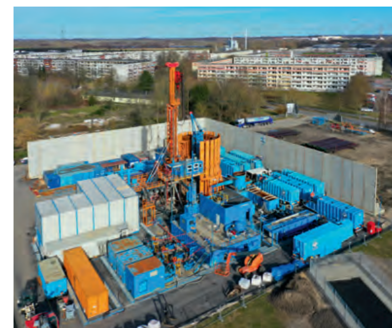
Um das Bohrgelände wurde eine Schallschutzwand erbaut, die die Emissionen der Anlage mindert
