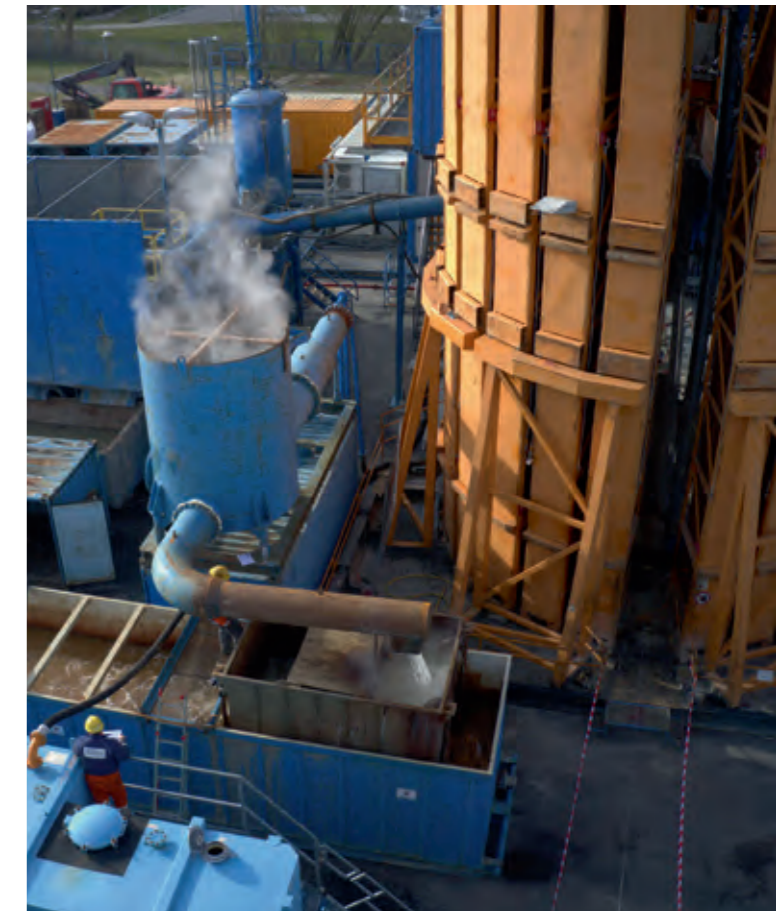
Der Dampf der gerade gefördert Thermalsole ist hier gut sichtbar
