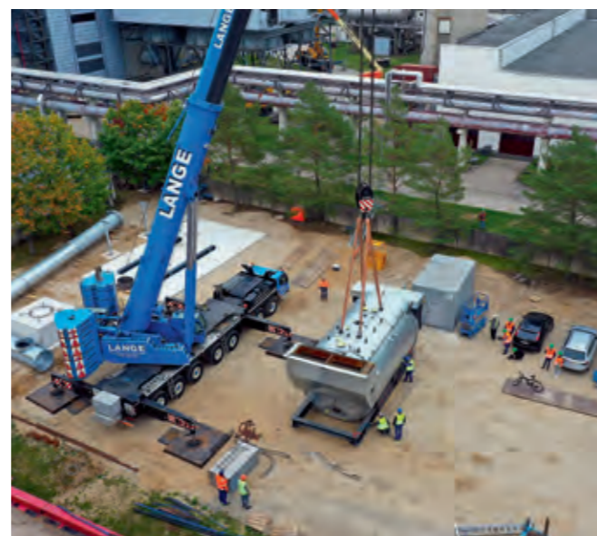
Nach knapp vier Stunden konnte der Kessel sicher auf seinem Fundament platziert werden
